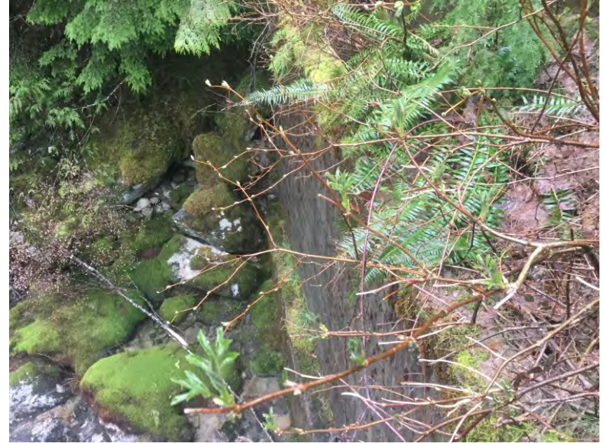
DS right bank wing wall
