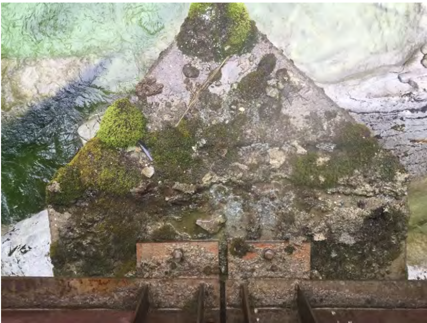
DS pier bearings
